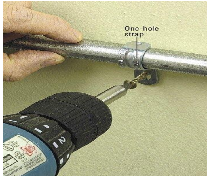
Figure 37: Step 5 Anchor Conduit
